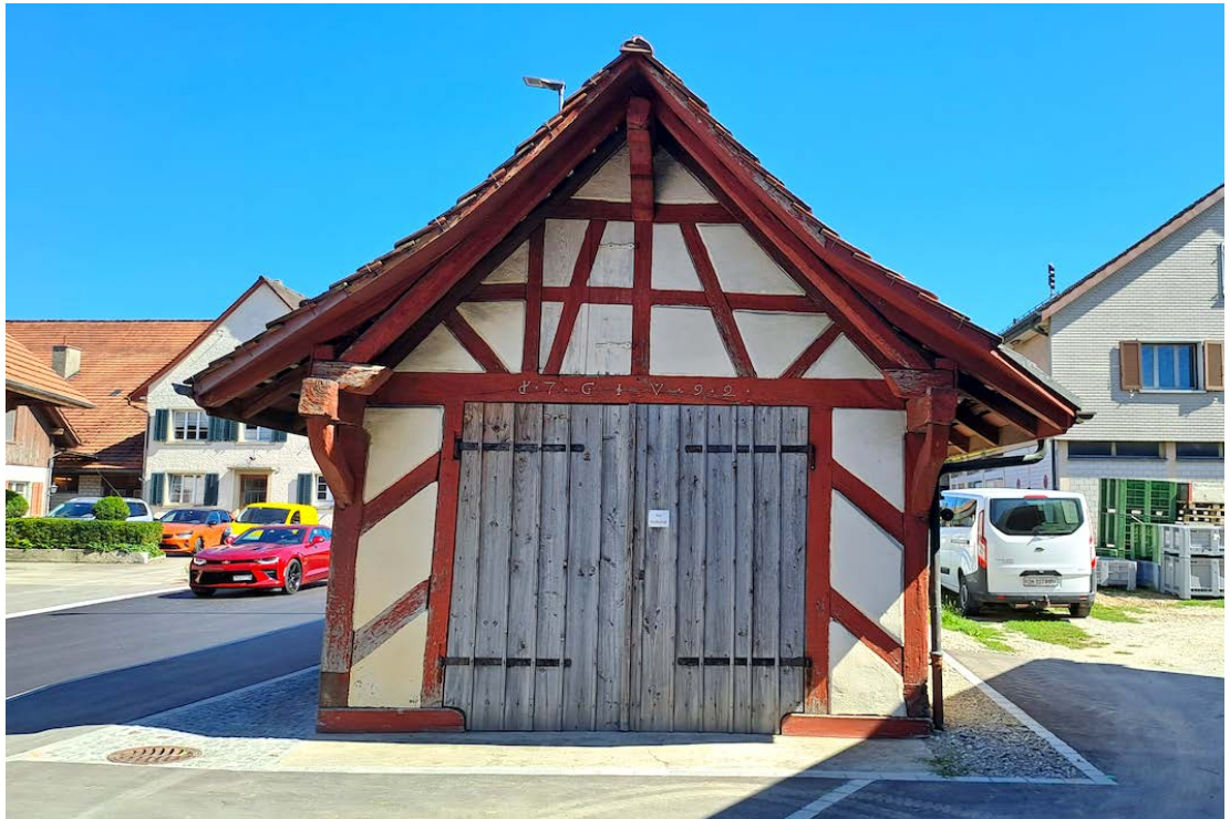
Ansicht westseitige Giebfassade mit zweiflügligem Eingangstor.
