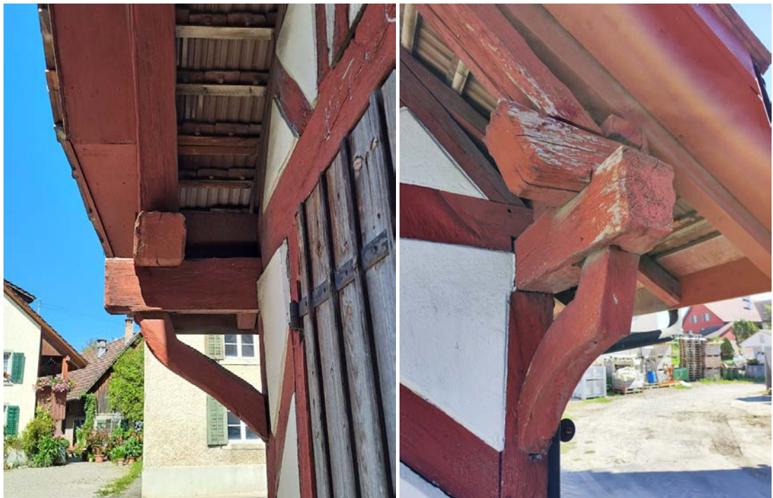
Detailansicht der Stützkonstruktion für den giebelwestseitigen Dachvorsprung.
