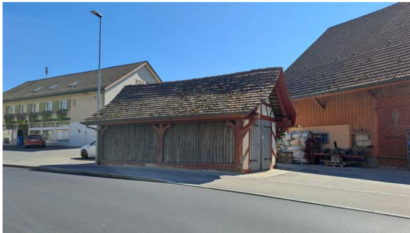
Flaachtalstrasse, Blickrichtung Ost.
