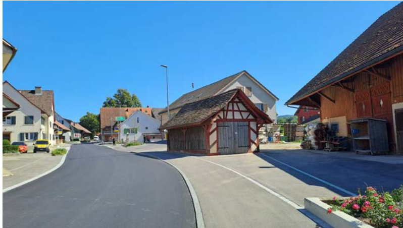
Flaachtalstrasse, Blickrichtung Ost.
