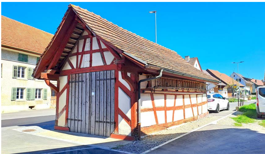
Ansicht des ehemaligen Spritzenhauses von SW.
