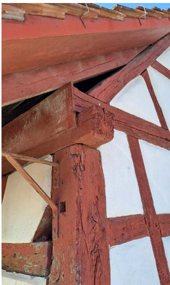
Traufsüdseite. L: Lüftungsöffnungen in den Gefachen mit schräggestellten Ziegeln; R: Kissenartiger Putzauftrag und behelfsmässig geschützte Schwelle.
