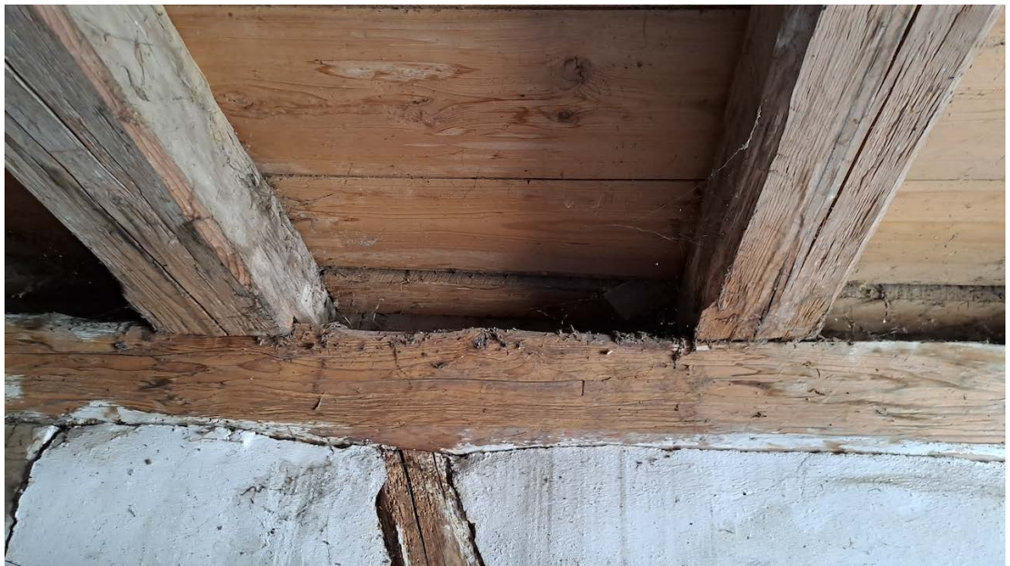
Balkenlage mit auslaufender Zierfase.
