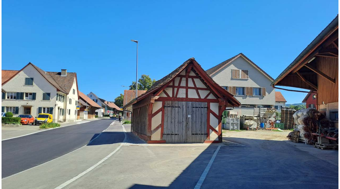
Ansicht des Strassenraumes Richtung Osten zum Gemeindehaus.
