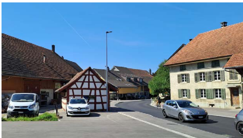
Flaachtalstrasse Blickrichtung West.
