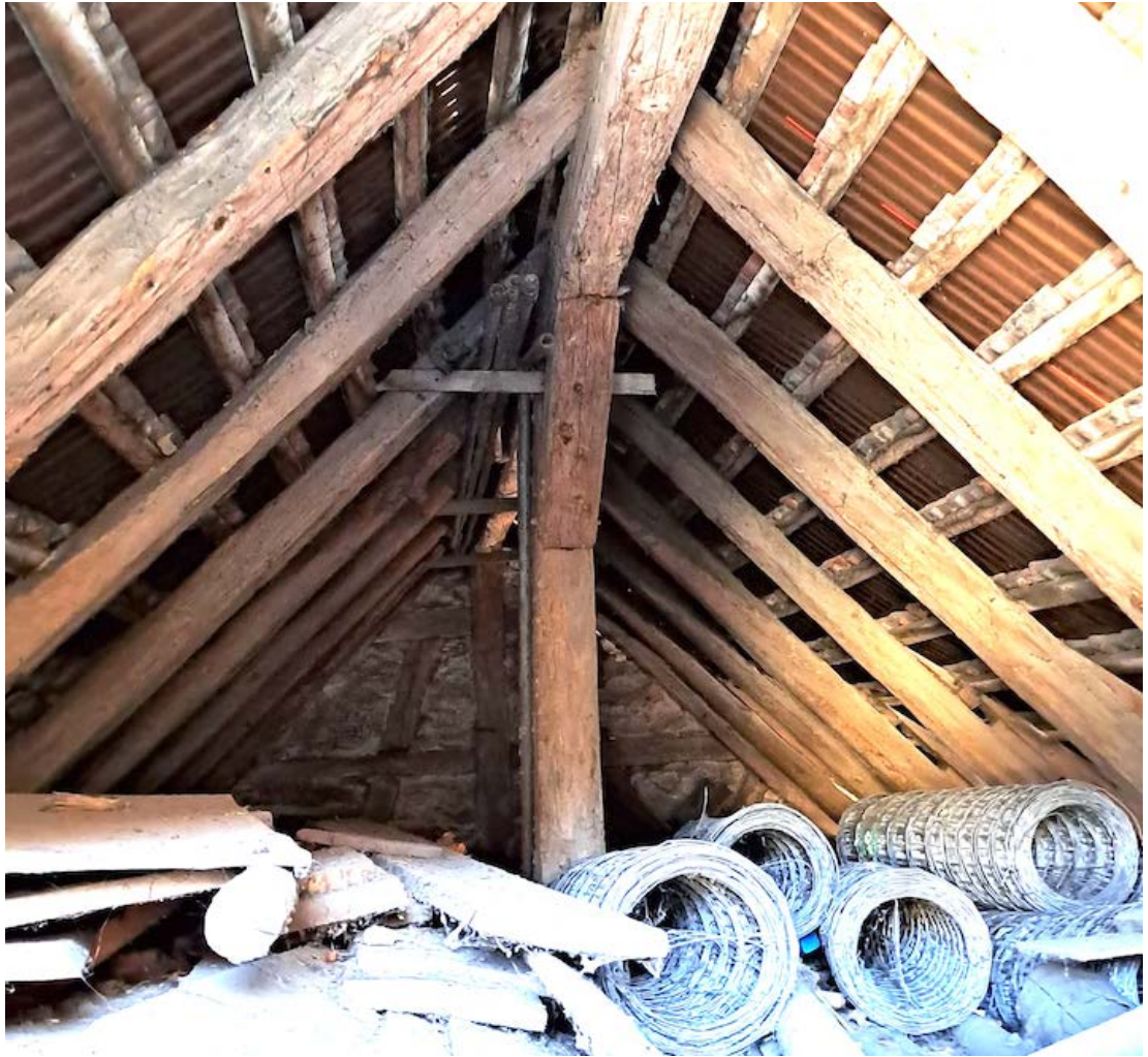
Blick ins Dachwerk mit Sparrenpaar, überblattet auf Firstbalken liegend, Firstständer mit Kopfstreben.
