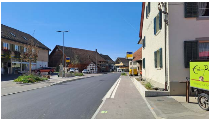
Flaachtalstrasse Blickrichtung West.
