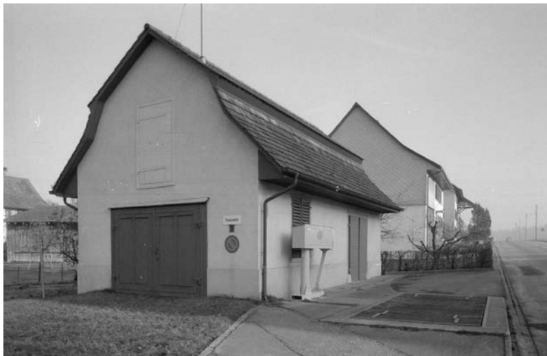
Ansicht des Oerlinger Spritzenhauses von SW.
