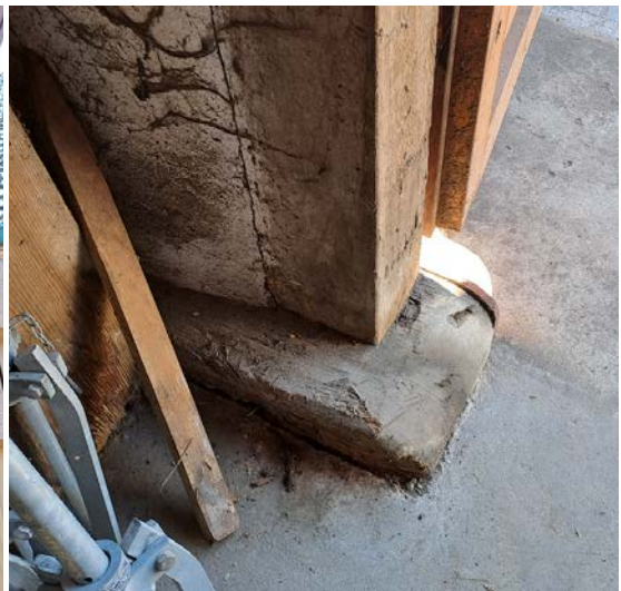
L: Ersetzter Pfosten an bauzeitlicher Lage. Auslaufende Zierfase weist auf unveränderte Öffnungsgrösse. R: Bauzeitliche Schwelle und ersetzter Türpfosten.
