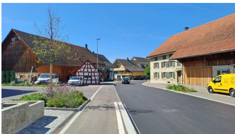
Flaachtalstrasse Blickrichtung West.
