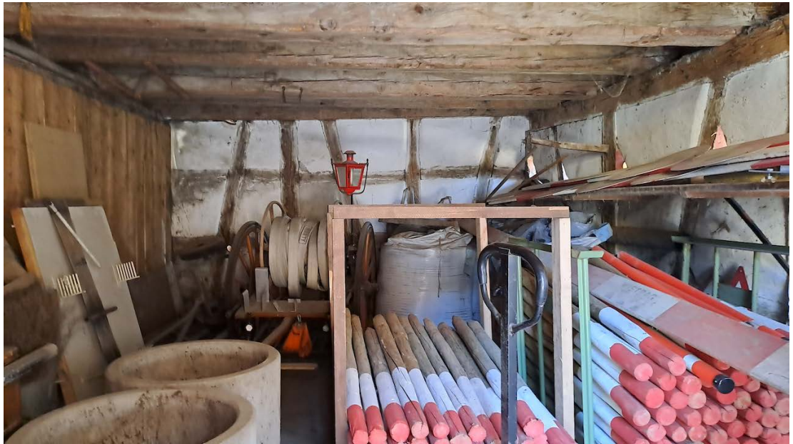
Blick nach Osten zur Fachwerkwand.
