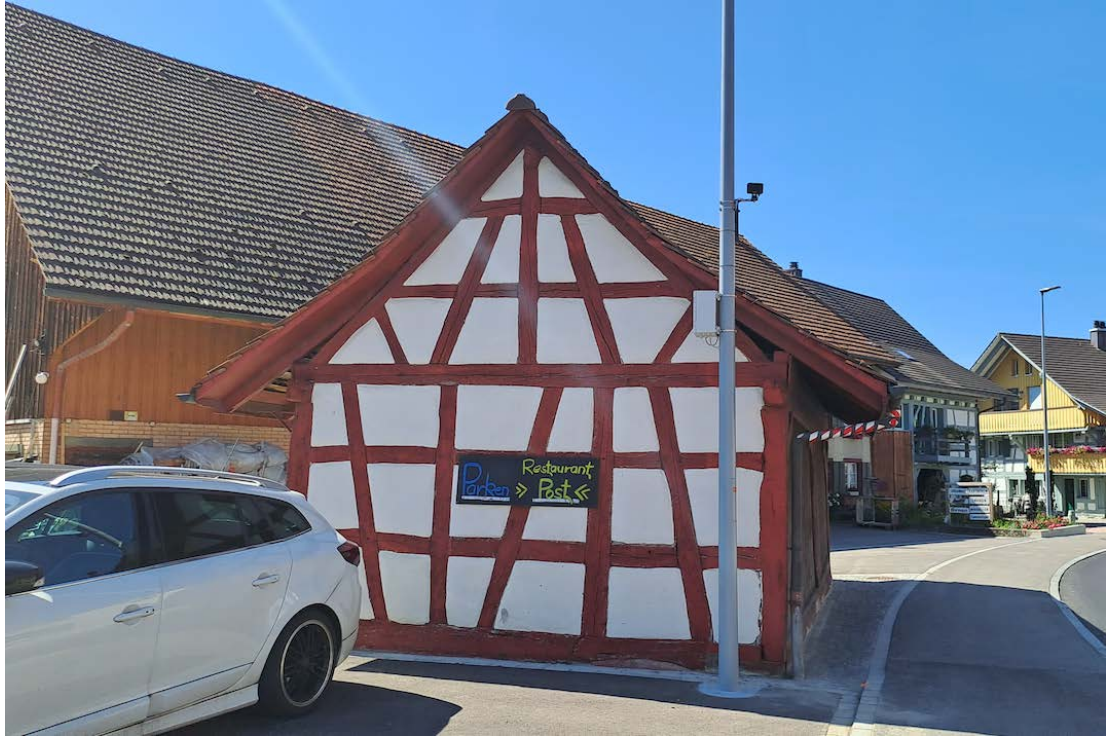
Ansicht ostseitige Giebelfassade.
