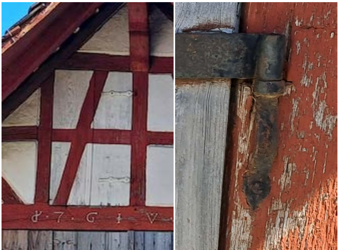
Detailansicht Bretttertür DG West (linkes Bild) und älterer Türkloben des Eingangstors EG (rechtes Bild).
