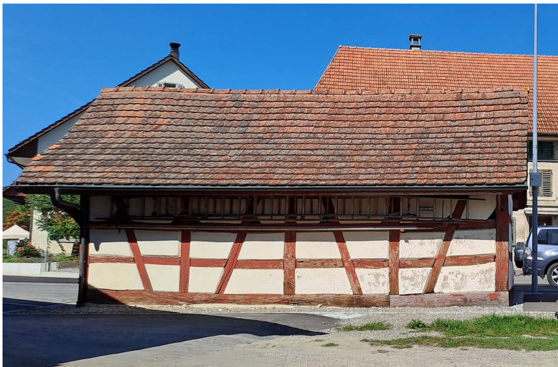
Ansicht südseitige Trauffassade.
