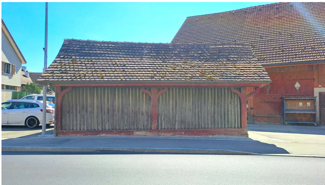
Ansicht nordseitige Trauffassade.
