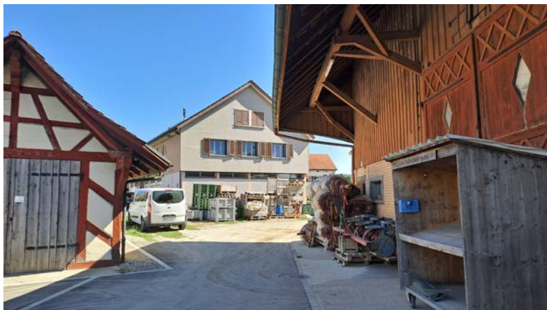
Hofraum vom Vielweckbauernhaus Flaachtalstrasse 25/27.
