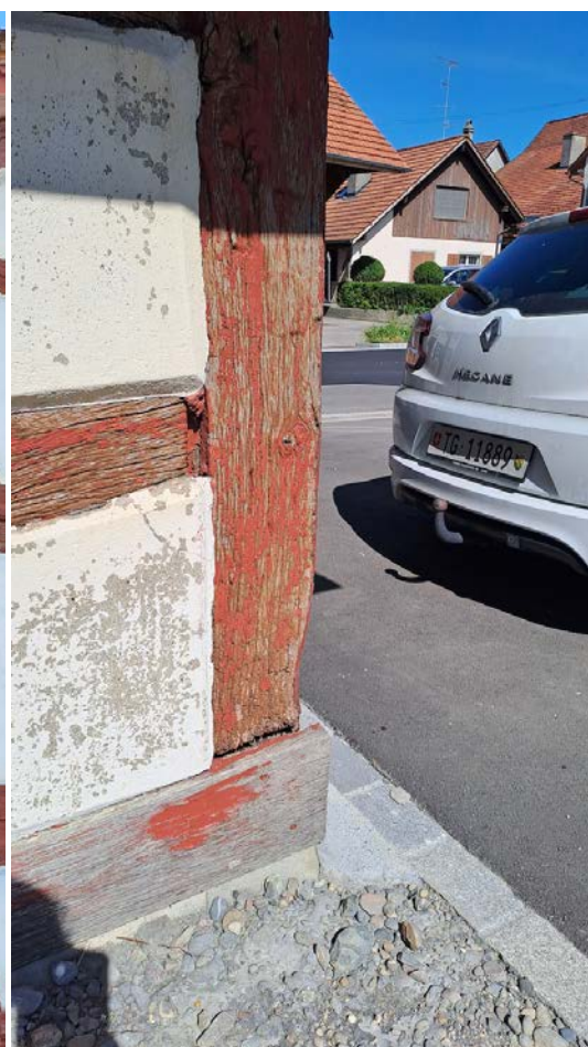
Traufsüdseite. L: Lüftungsöffnungen in den Gefachen mit schräggestellten Ziegeln; R: Kissenartiger Putzauftrag und behelfsmässig geschützte Schwelle.
