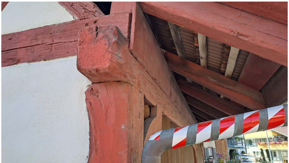
Blick auf Dachuntersicht strassenseitig. Bauoriginale Primärkonstruktion mit nachbauzeitlich ersetzter Aufschieblingslage auf Schwellholz.
