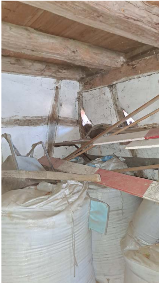
Innenseitig noch bauoriginal flächiger Putzauftrag.
