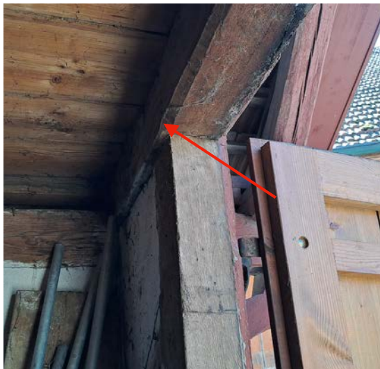
L: Ersetzter Pfosten an bauzeitlicher Lage. Auslaufende Zierfase weist auf unveränderte Öffnungsgrösse. R: Bauzeitliche Schwelle und ersetzter Türpfosten.
